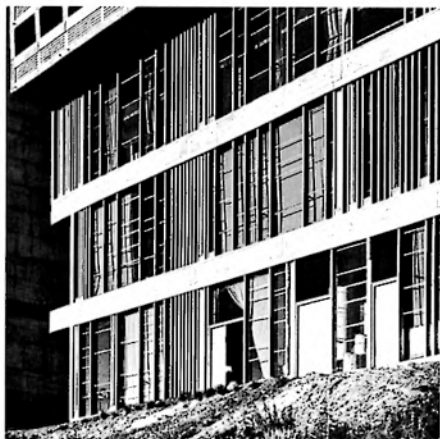
fig. 46 Gradation «ondulatoire» des vitrages; Le Corbusier, couvent de la Tourette.
